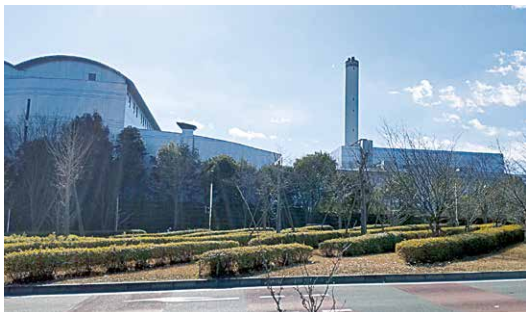
清掃工場で出た熱はこれまでアクアブルーのプールで使用。今後は熱で発電した電力を自家消費の他、余剰分を公共施設で使う予定。
